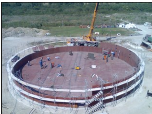
Šećerana "Donji Srem" Pećinci, Srbija - rezervoar 12000 m 3 (2010.)
